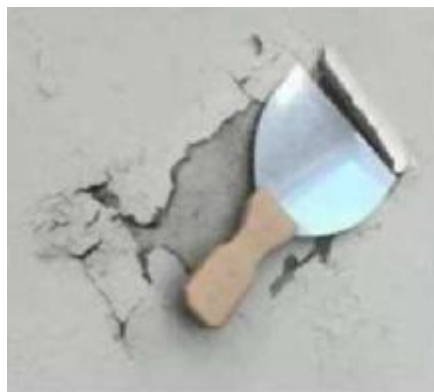
Рис. 2.3. Очистка поверхности шпателем.
