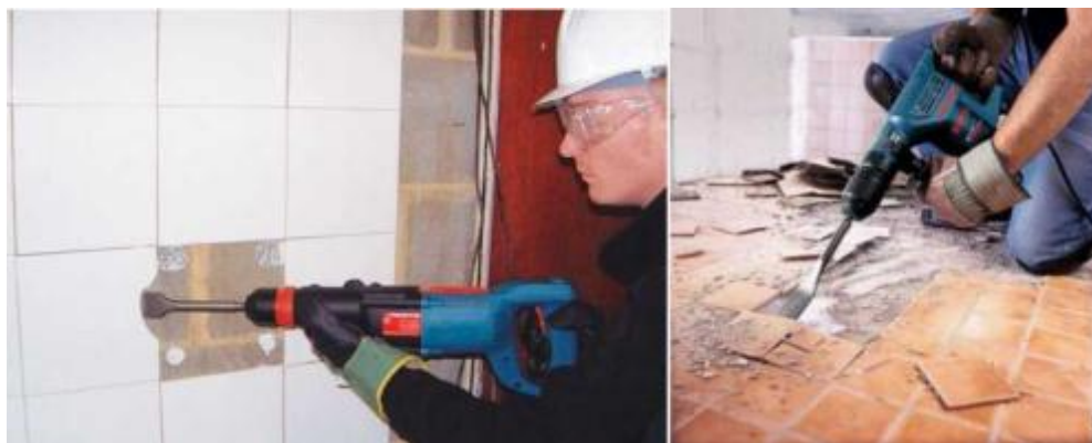
Рис. 2.2. Удаление плитки перфоратором
