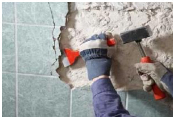
Рис 2.1. Удаление плитки зубилом или долотом
