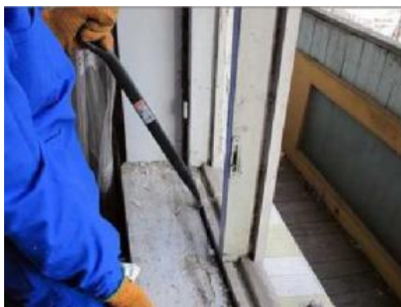
Рис. 2.5. Демонтаж оконной рамы монтировкой
