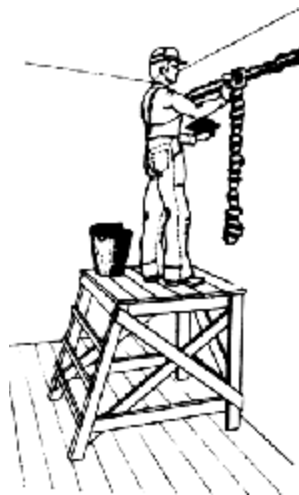
Рис. 2.18. Установка и крепление соединительных коробок и деталей крепления под приборы
