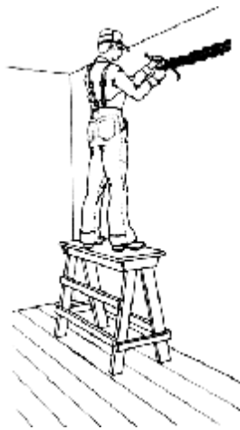
Рис. 2.19. Зачистка концов проводов от изоляции для присоединения светильников
