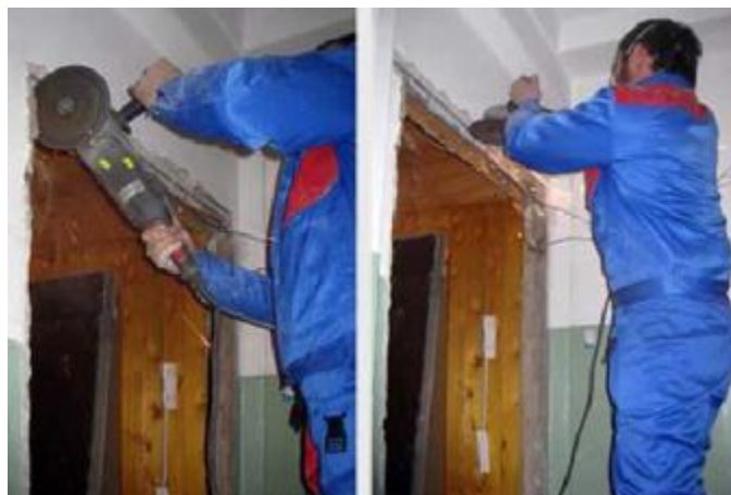
Рис. 2.4. Разрезка дверной коробки болгаркой
