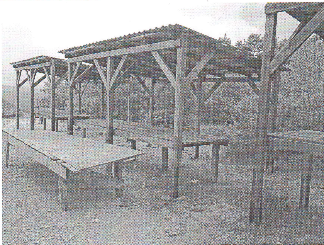
Временное сооружение №2 (торговый объект № 2) площадью 10,1 кв.м., расположенное по адресу: Республика Крым, Бахчисарайский муниципальный район, Бахчисарайское лесничество, Михайловское участковое лесничество, квартал 46 выдел 11,
