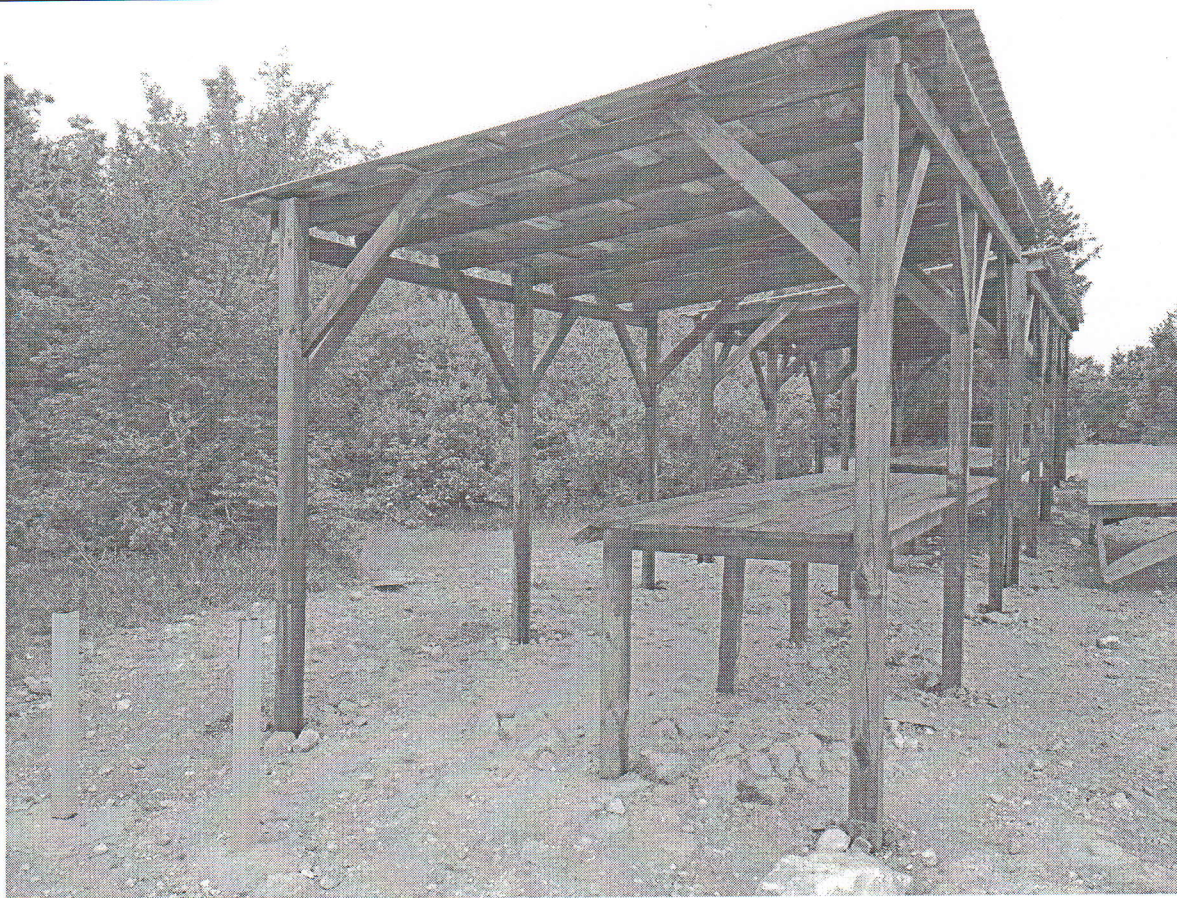
Временное сооружение №2 (торговый объект № 3) площадью 10,1 кв.м., расположенное по адресу: Республика Крым, Бахчисарайский муниципальный район, Бахчисарайское лесничество, Михайловское участковое лесничество, квартал 46 выдел 11
